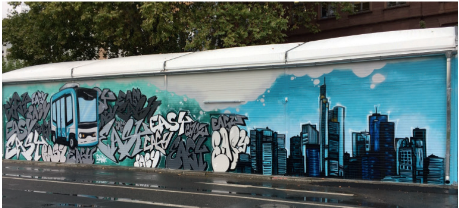
Abb. 4: Abstellhalle für die Fahrzeuge.
